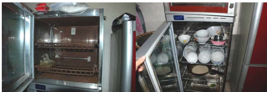
图 15 消毒柜成了碗柜（未接电正常使用，且上层已生锈）
