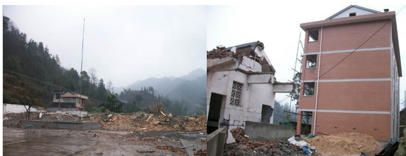
图 5 拆掉的教学楼
