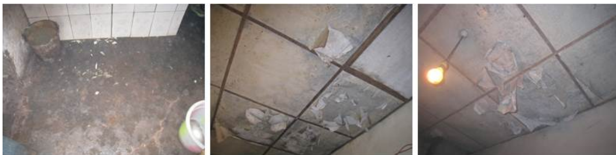
图5 厨房墙面地面情况组图
