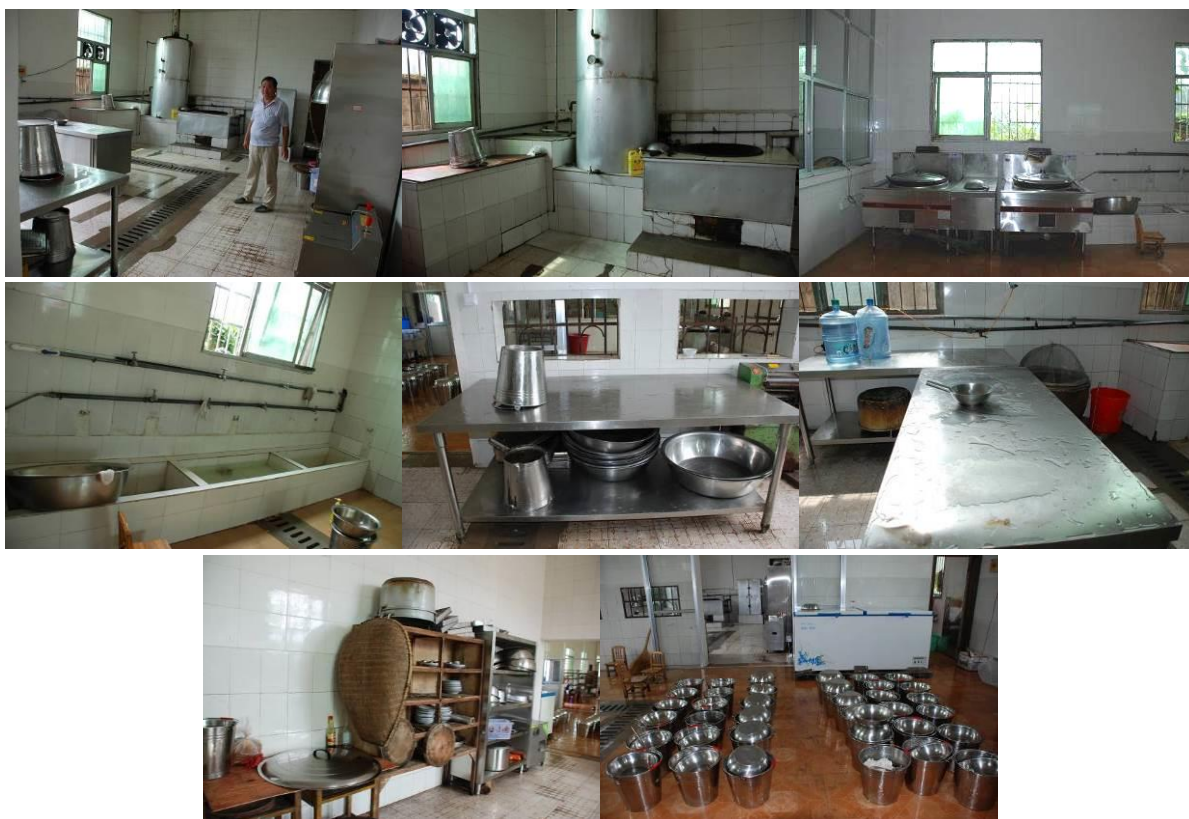
图 8 学校厨房修缮后
