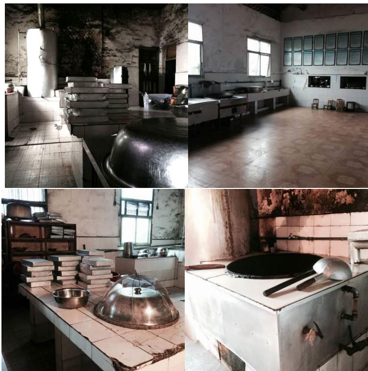
图 7 学校厨房修缮前
