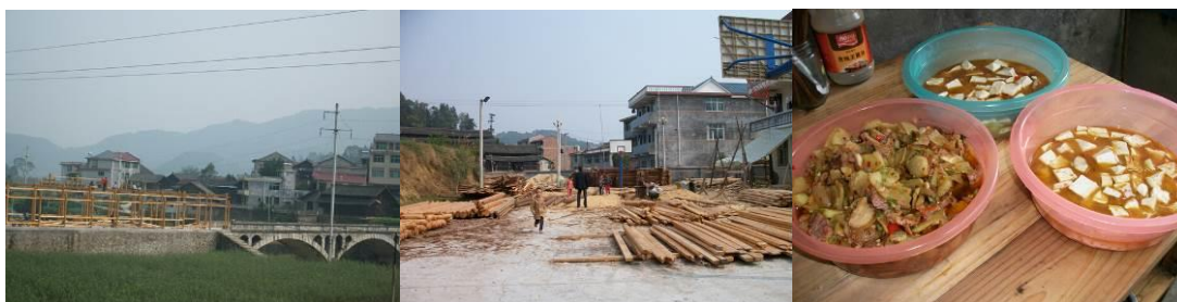
图 2 在建的风雨桥
