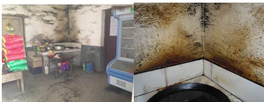
图5 厨房全景及局部
