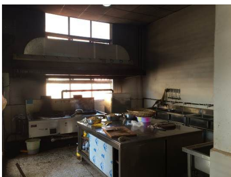
图5 厨房操作间全景
