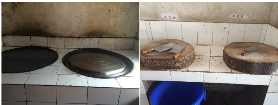
图6 厨房操作间灶台及工作台
