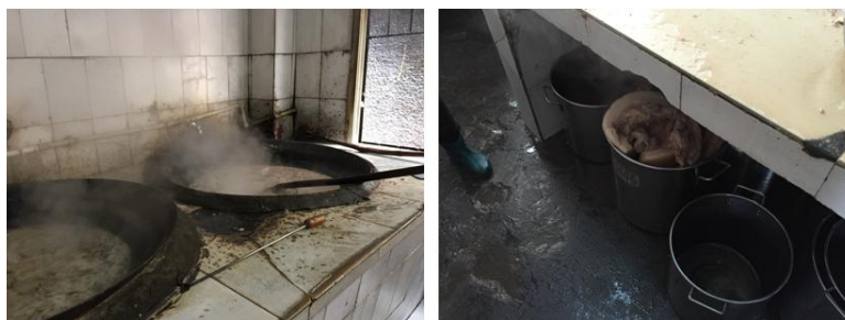
图8 厨房墙面和地面情况组图
