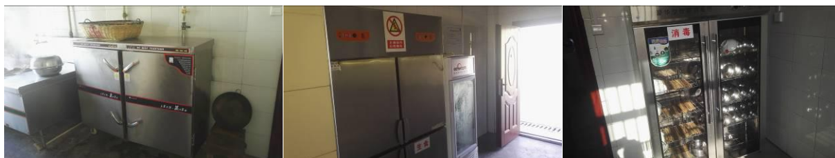
图 17 正常使用的厨房设备组图
