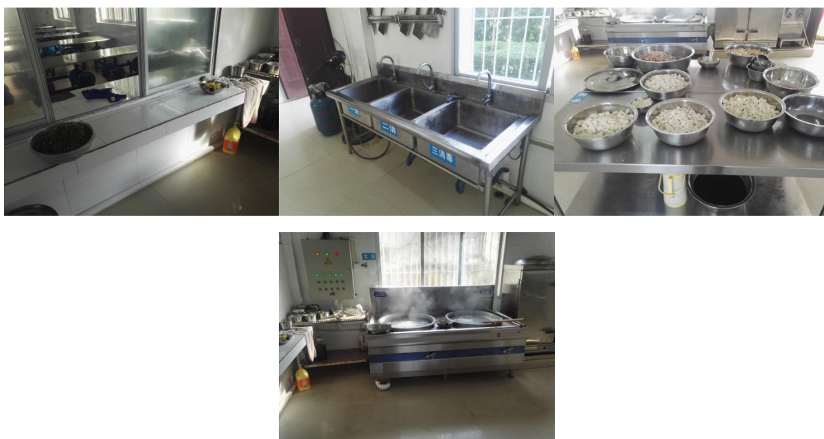
图 I -2 厨房卫生情况组图
