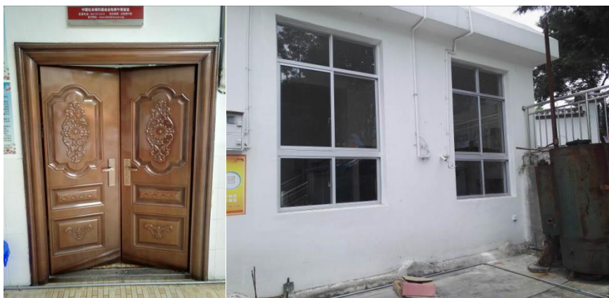
图 20 修缮厨房实物情况组图
